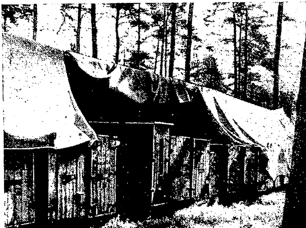
Рис. 14. Хранение оборудования с использованием навеса
